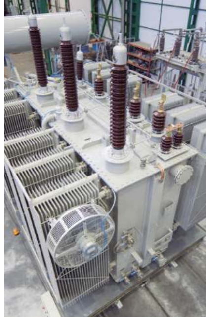
Plataforma para ensayos de potencia
